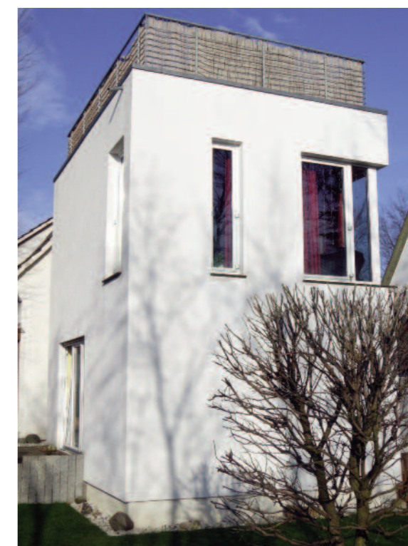
Die Anordnung der Fenster im Anbau folgt der Funktionalität der Innenräume.
