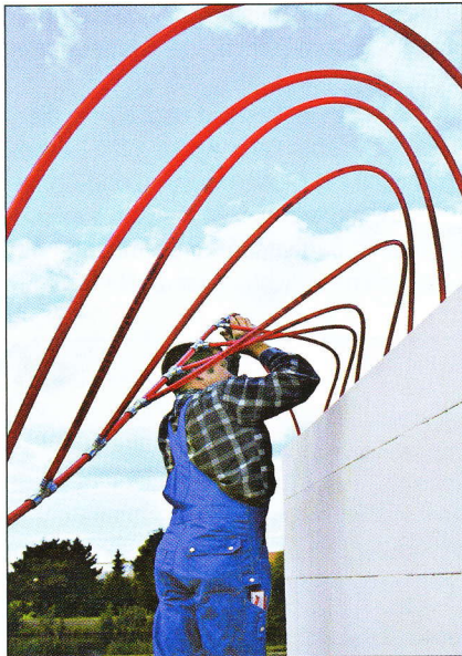
KS-Quadrotherm: Die Heizungsrohre werden während des Rohbaus über die gesamte Wandhöhe durch die senkrechten Installationskanäle der Außenwand geführt.
